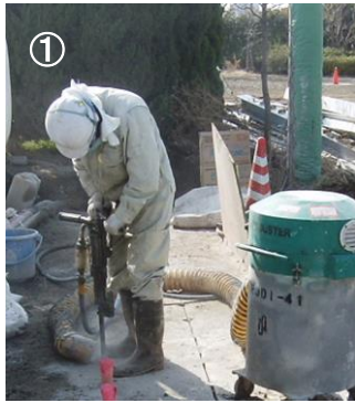
①削孔計画に沿って削孔を行う
