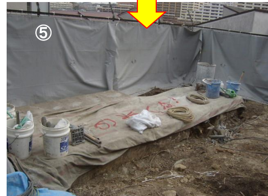
⑤薬剤の充填が終了した後、噴出現象により薬剤が飛び散る場合があるので、防護シートで
