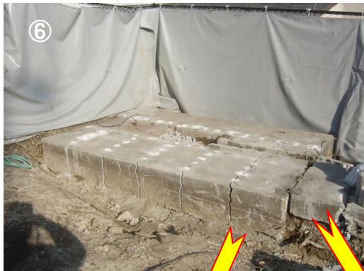
①削孔計画に沿って削孔を行う
