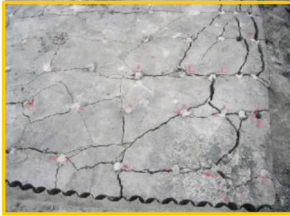
破砕例:ブライスター(大孔径用)で亀裂が入った状況
