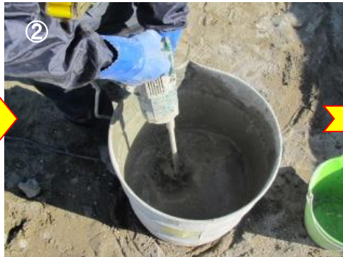
②充填に必要な量を計量して水と練り混ぜる
