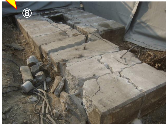
⑥⑦⑧亀裂発生を確認できたら防護シートを剥がし、二次破砕又は後処理を行う。
