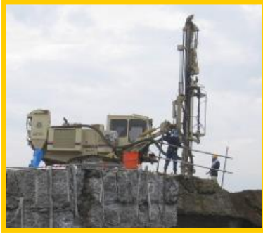
大孔径は クローラドリルで削孔
