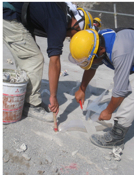
孔口から20cm位のところで切断する
