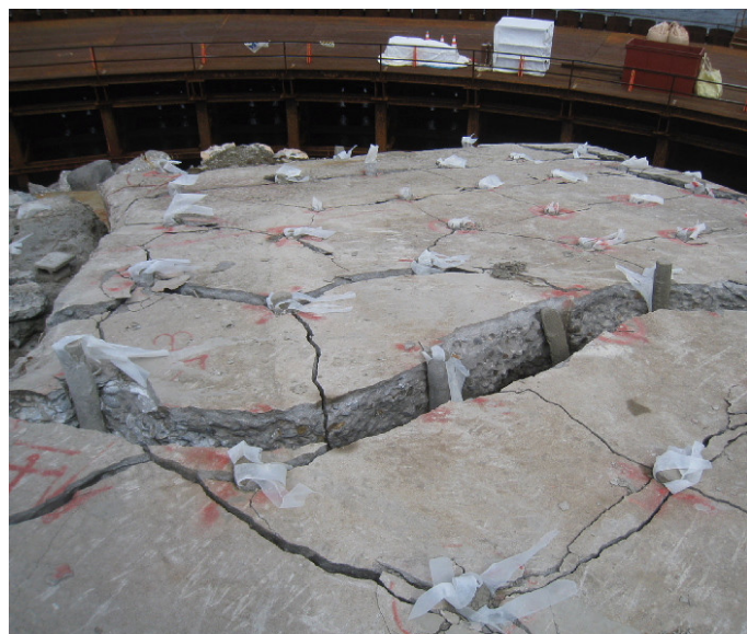
2 上部亀裂発生状況
