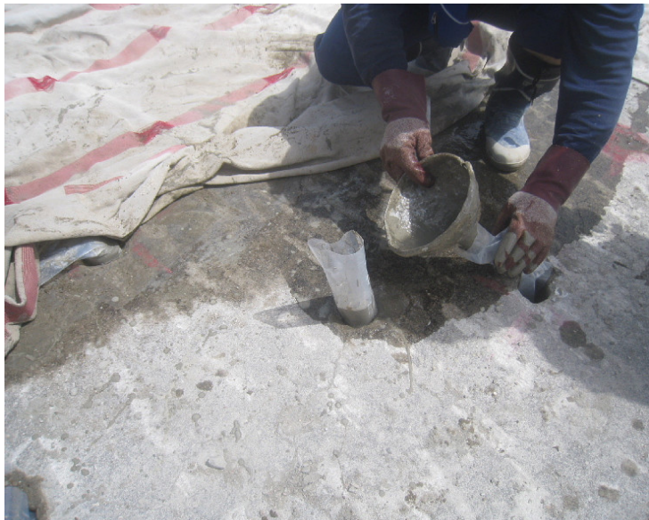
ポリチューブの先端に漏斗を挿入
