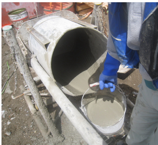
40kgの膨張剤を6個のバケツに取り分ける
