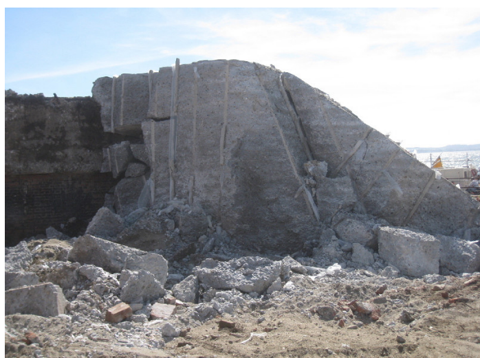
2 削孔の跡がはっきりと確認できる
