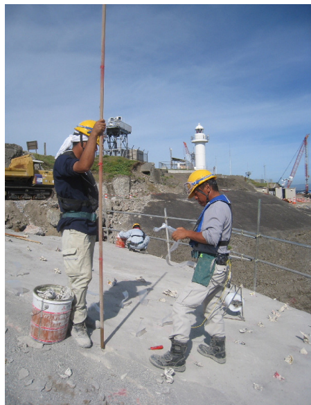
200mロール巻のポリチューブの先端を 強く締める
