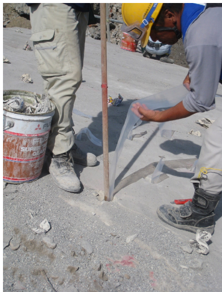
込め棒でポリチューブを孔尻まで挿入する
