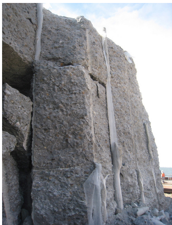
2 破断面の状況
