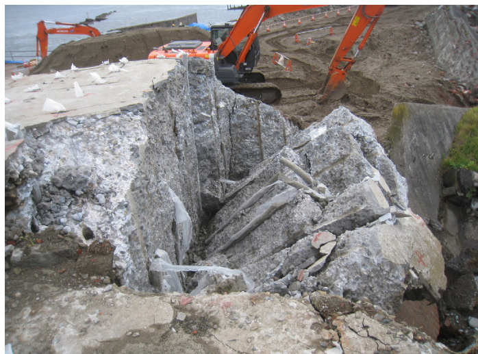
2 側面亀裂発生状況
