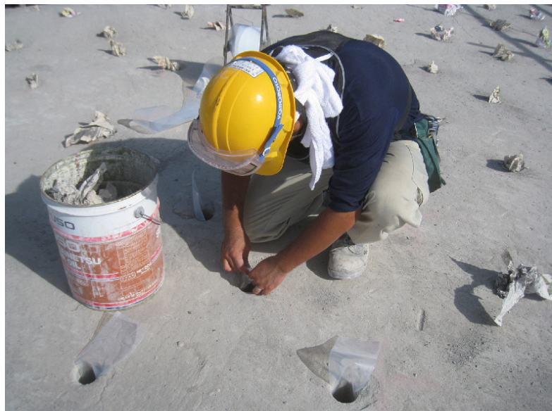
膨張剤の装てん前に各孔のポリチューブの先端を開いておく
