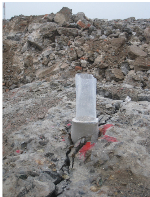
ポリチューブと膨張剤の反応状況
