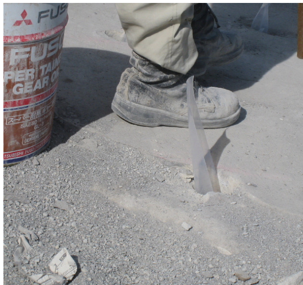
孔に挿入されたポリチューブの状況
