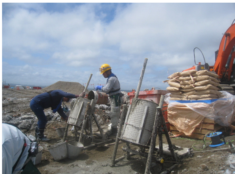
ブライスター2袋分(40kg)の海水(12ℓ)を計量してタンクに注水
