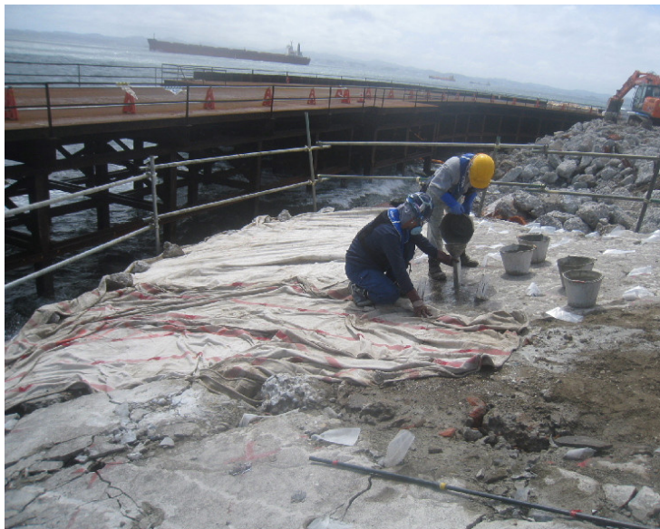
装てんが終了した孔には噴出防護用の防爆シートを被せる
