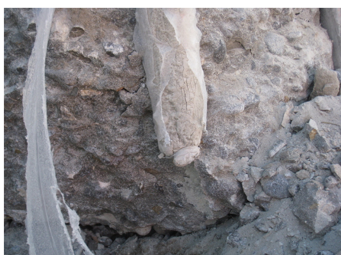
2 ポリチューブの先端部の薬剤膨脹状況
