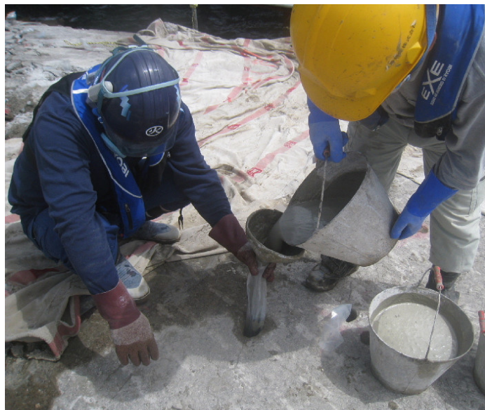
小分けしたバケツで挿入 孔内に水があっても孔とポリチューブの隙間から排水される
