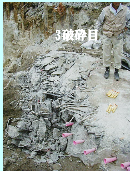
3回の破碎でかなり細かく碎かれた状況
