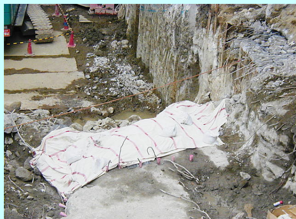
防護作業終了全景、回路テスターで破碎回路の抵抗を確認し、 他の作業員に着火時間を知らせ退避完了を待ってから着火器 で点火を行う。
