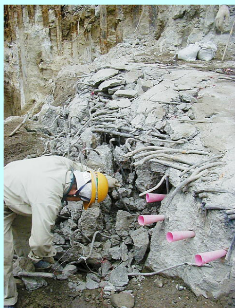
3回の破碎で鉄筋上部も細かく碎かれた。
