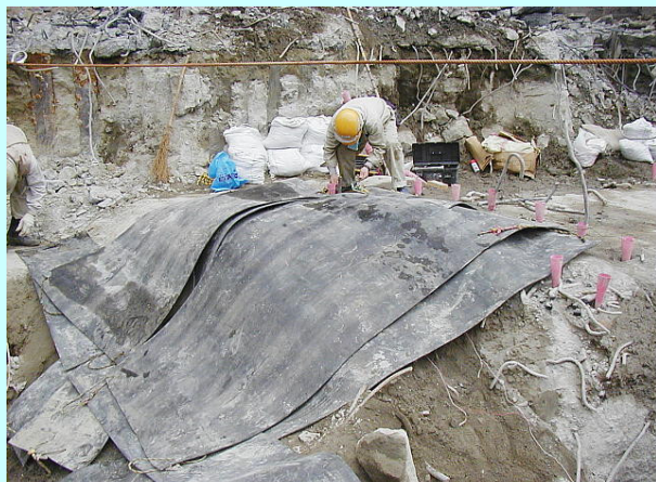
結線終了後、光電池式導通試験器で破碎回路の導通を調べ 防護用ゴムマットを破碎箇所へ覆う
