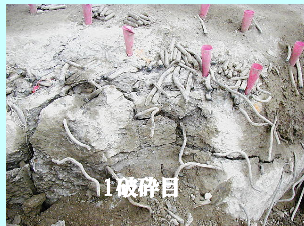
防護材を撤去し、破碎状況を確認する。1破碎目の破碎状況。
