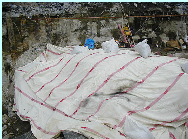
ゴムマットの上から防爆シートを被せ、重しに土のうを置く
