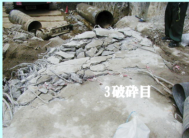
3回の破碎で鉄筋上部も細かく碎かれた。
