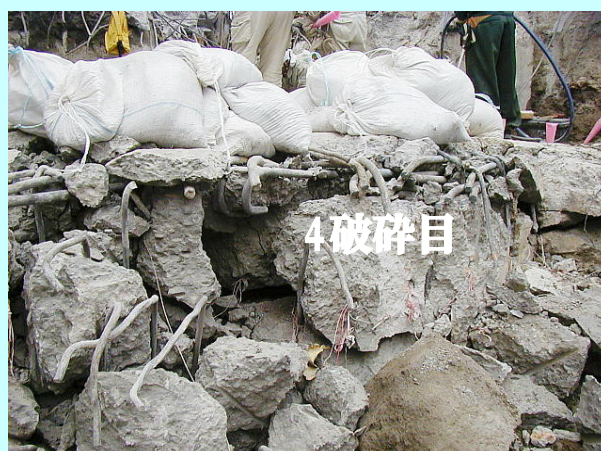
4破碎目の破碎状況。上部鉄筋の上には、目立った亀裂は入らなかったが鉄筋よりも下は、細かく碎かれた。
