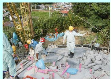
結線が終了すると、光電池式導通試験器で回路の導通を確認後、防護用のマットを被せる。
