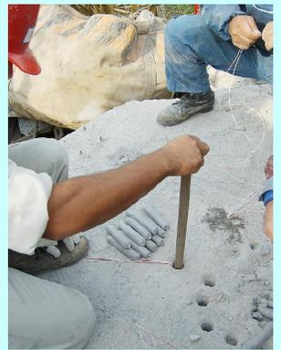
装てんする孔に込め棒を差し込み、削孔長及び孔内の状況を確認する。
