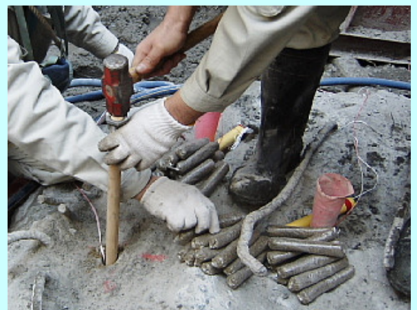
2本目は軽く叩き、3本目以降は強く叩き 孔口まで装填する（脚線の切断に注意）
