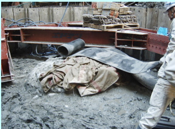
破碎する孔口部分に濡らした防爆シート（防音用）を置く
