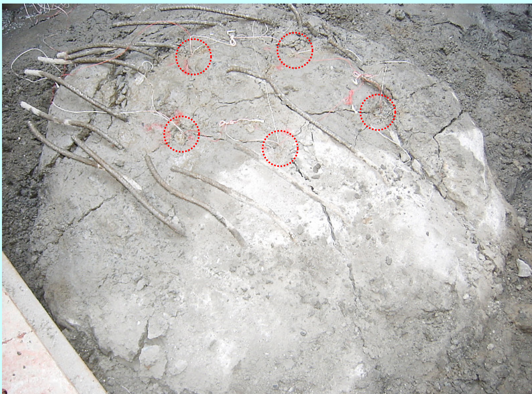
反対側から見た状態 振動値：上下方向 7 4 db、左右方向：7 5 db ( 水平距離 1 0 m )
