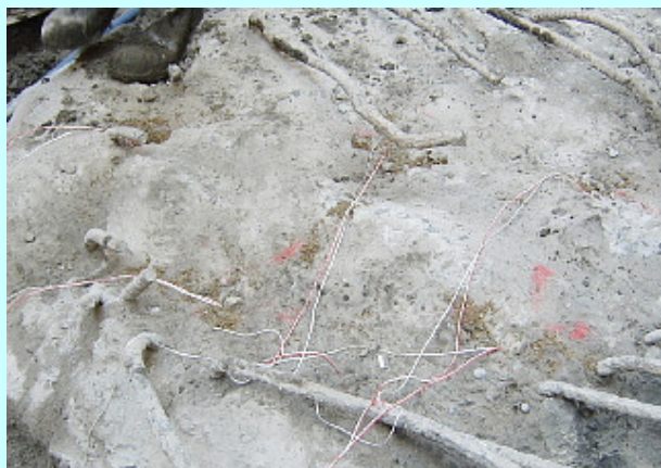
各孔から出ている脚線を直列に結線する
