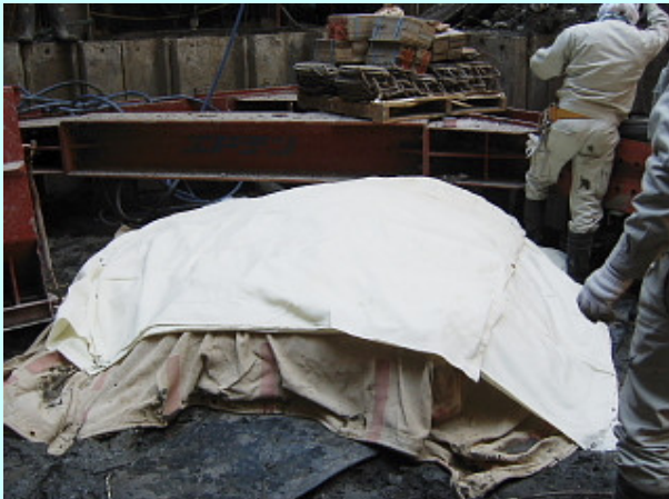
ゴムマットの上に、防爆シートを被せる
