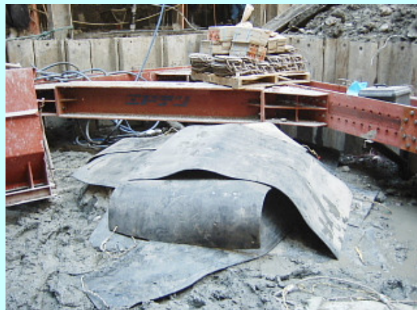
防護・防音用のゴムマットを被せる
