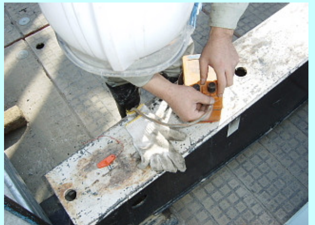
他の作業員の退避を確認後、着火器に母線を接続する
