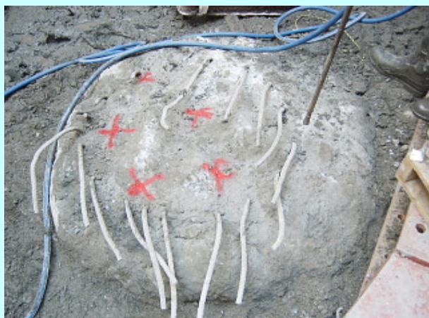
削孔位置確認 孔間隔：40 cm 孔数：5本
