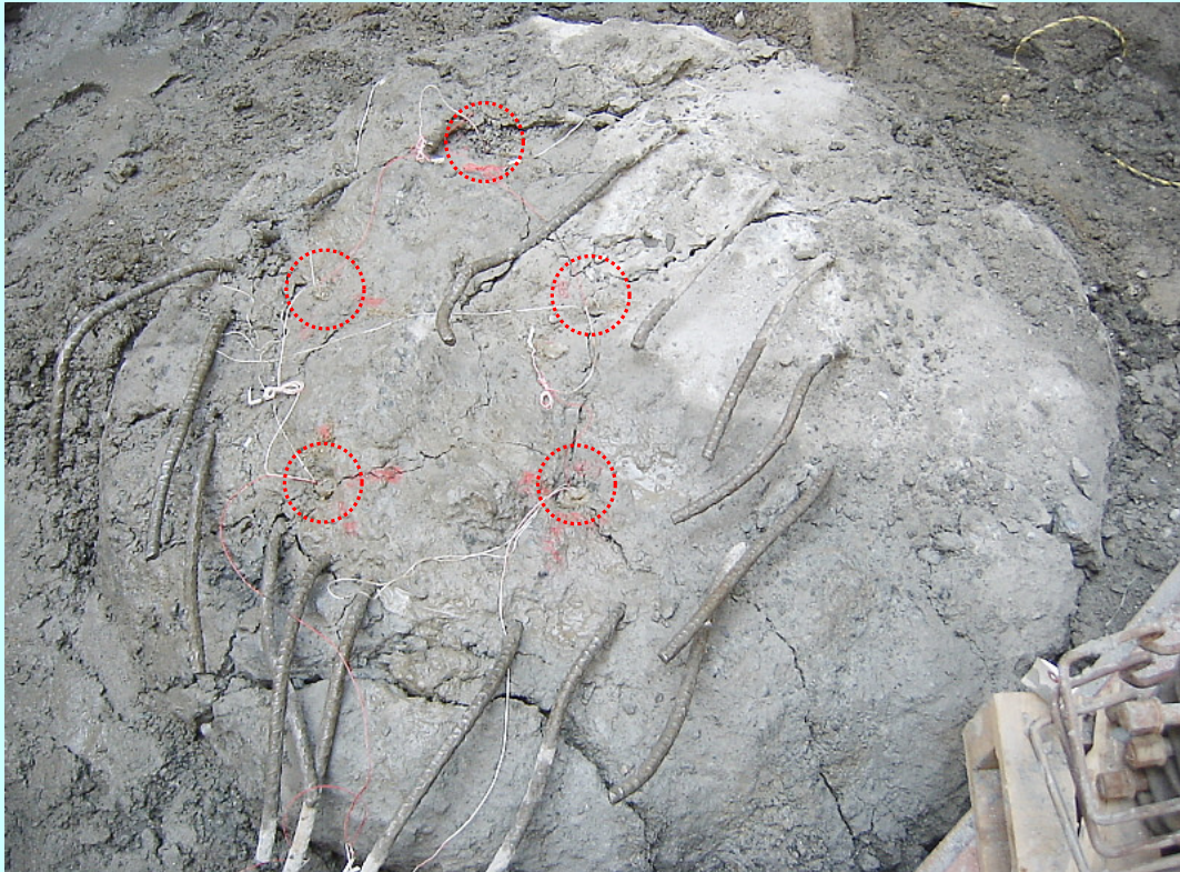
着火後の杭の状態 孔間以外にも多数の亀裂が入った
