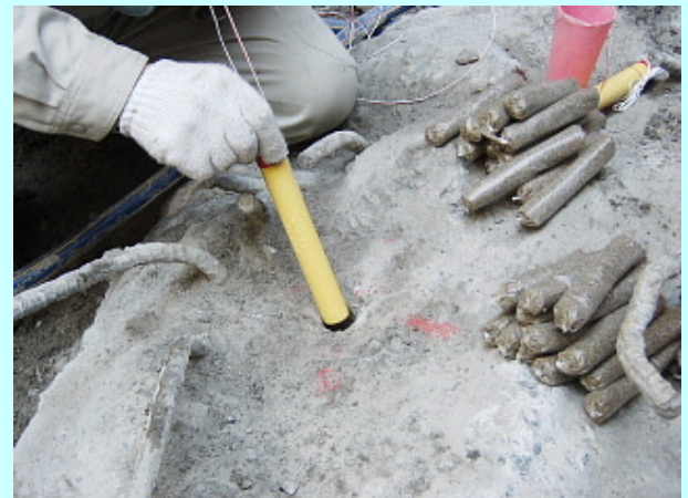
ガンサイザーの装填（着火具側を下にする）
