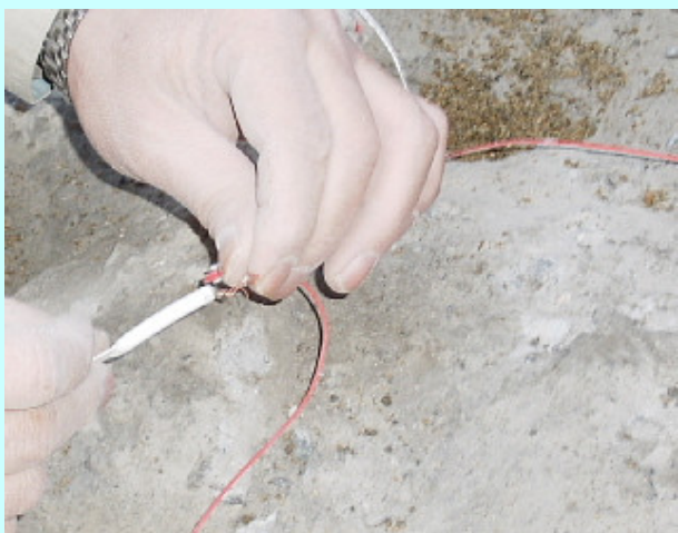
結線部をプロタイトで絶縁する（リーク防止）
