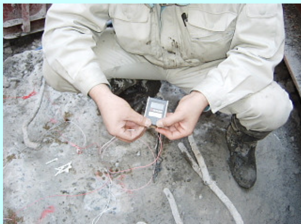
結線終了後、破碎回路の導通を調べる
