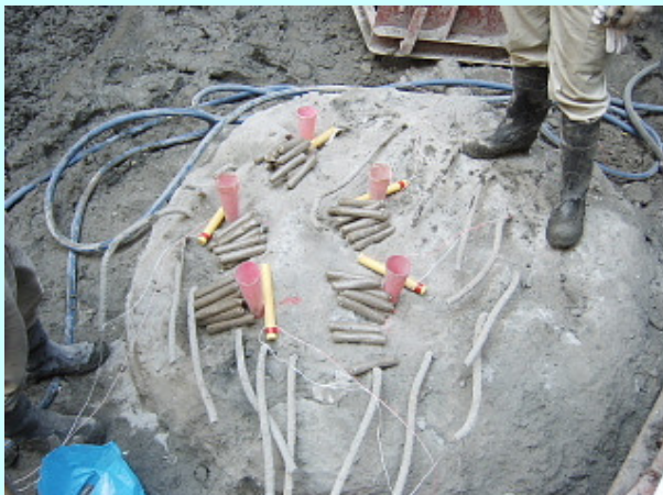
装填箇所にタンピング用の砂を用意する
