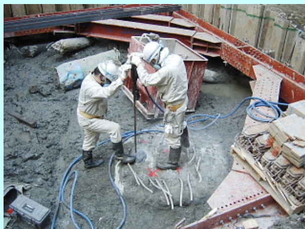
削孔状況 削孔径：32 mm 削孔長：1.0 m
