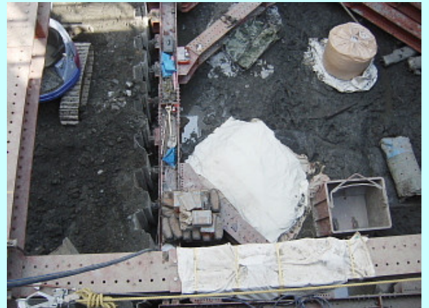
点火位置から見た破碎場所
