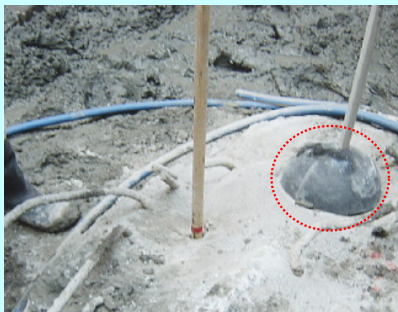
削孔長の確認 1.0 m
